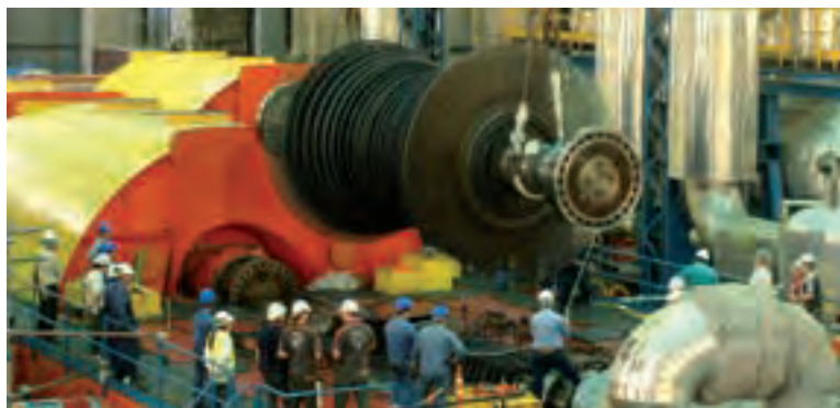
Installation of a turbine / Il posizionamento di una turbina
