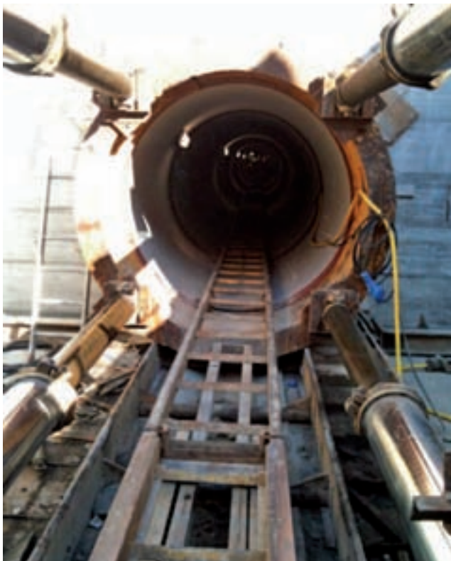
Cosoletto minihydro power plant (Cosoletto, Italy), tunneling works. Civil works design by Cresco Centrale miniidroelettrica Cosoletto (Cosoletto, Italia), costruzione delle gallerie. Progetto delle opere civili a cura di Cresco
