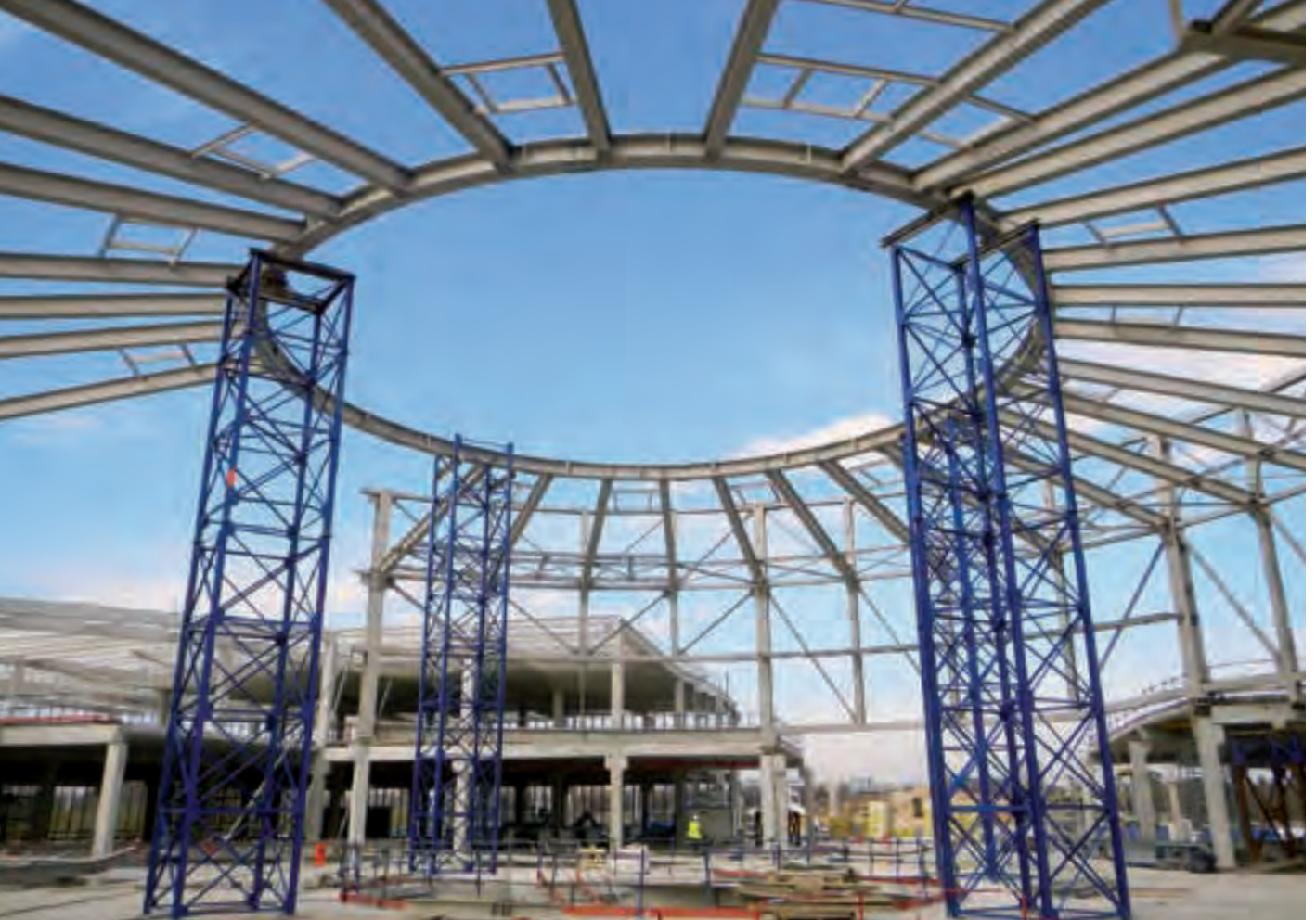
Place Nord erection Montaggio Place Nord
