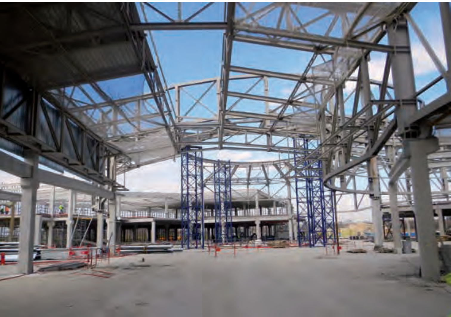
Place Nord assembly Montaggio Place Nord
